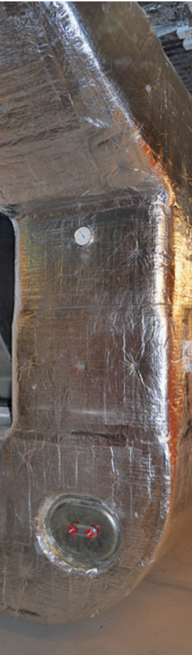
Gedämmter Lüftungskanal
