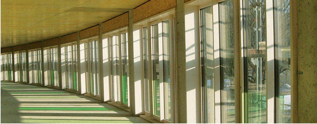
Internatsfassade im Rohbau
