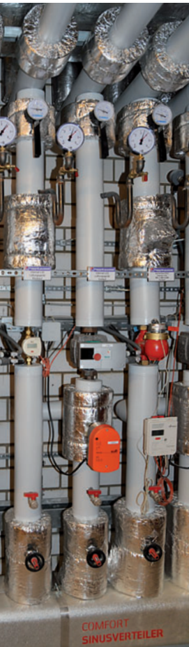
Heizkreisverteiler
