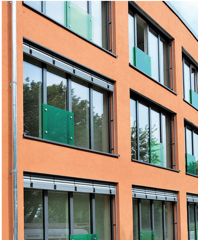
Fassade der Internatszimmer
